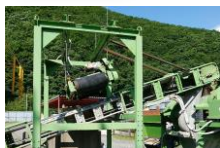
ベルトコンベヤ修理
