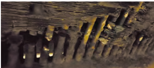
二次空気予熱器（漏れロウ付け修理）
