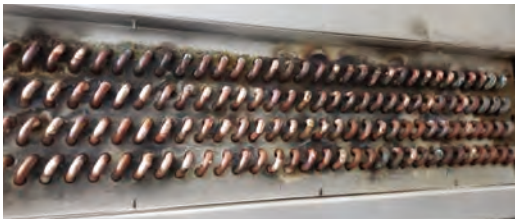
医療機関 空調機（漏れロウ付け修理）
