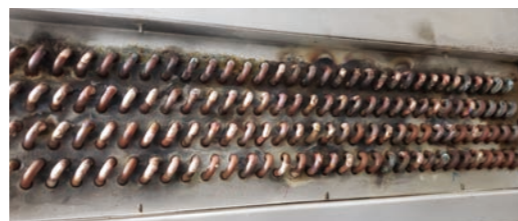
医療機関 空調機(漏れロウ付け修理)
