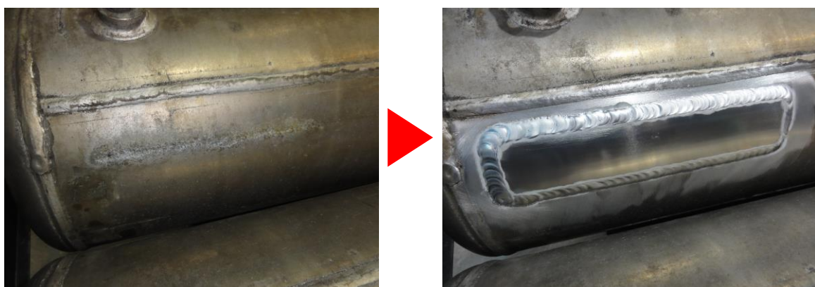
〈修理例：エアータンク修理〉
